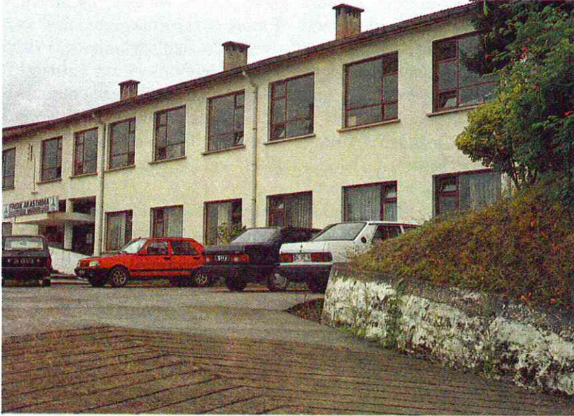
Resim.1. İdare Binasının Genel Görünüşü.
