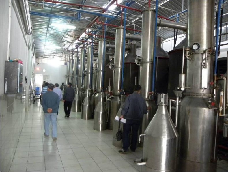
Resim 3. Gül yağı üretim tesisi
