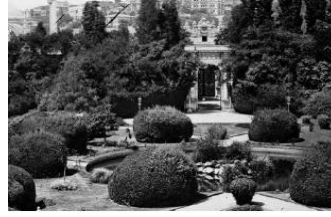
Şekil 2. 1880 yılına ait Dolmabahçe Sarayı hasbahçe görünümü (Seçen, 2011)
