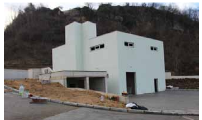
Şekil 5. Projenin C Bloğu (Hammum/Temel Petek İşleme Tesisi)
