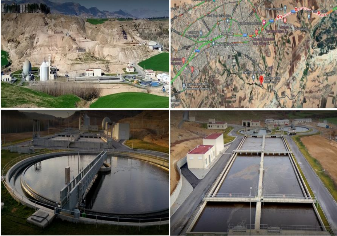
Şekil 1. Adıyaman ileri biyolojik atıksu arıtma tesisinin genel görünüm (Anonim, 2022)
