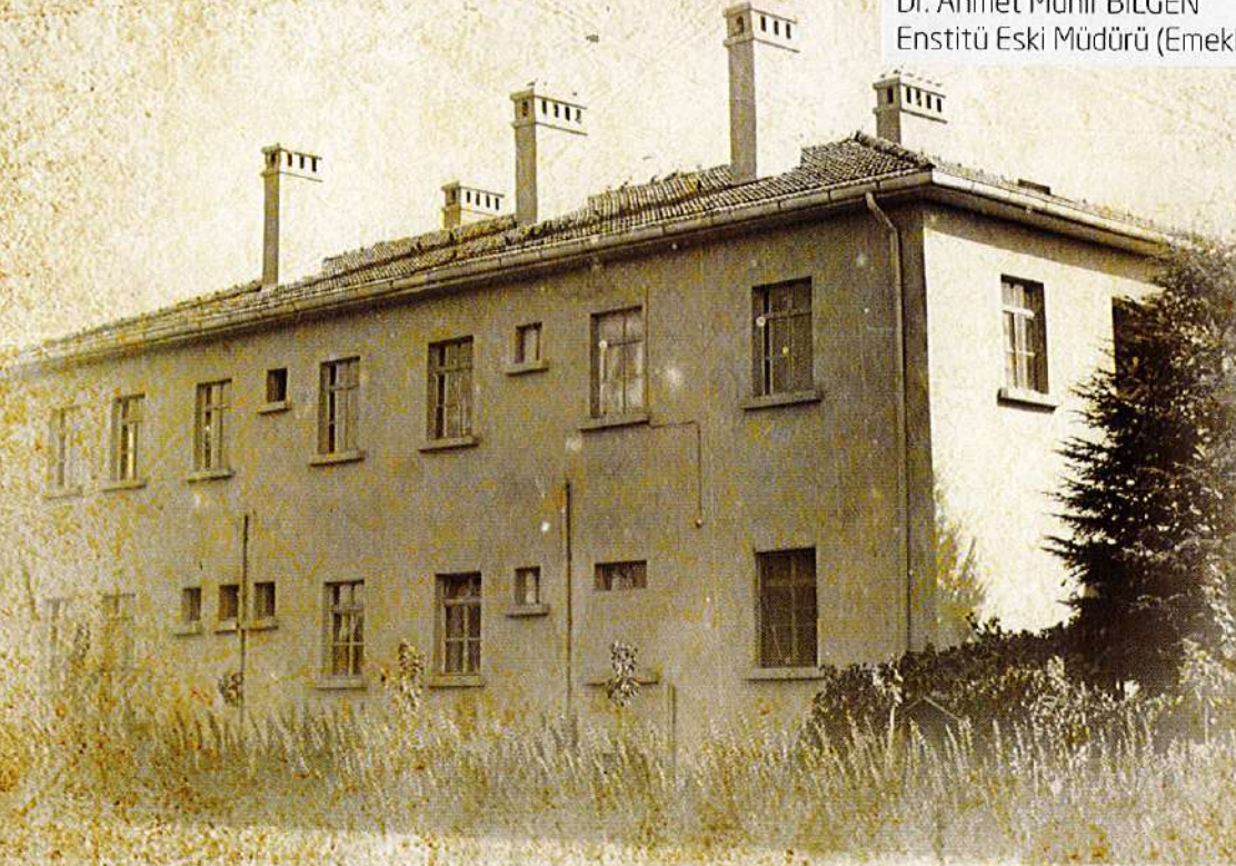
Eski Hizmet Binası
